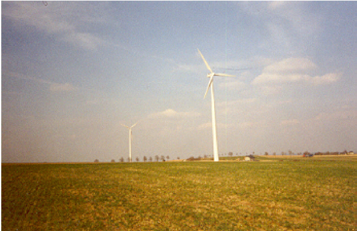
Les éoliennes de Megawind
